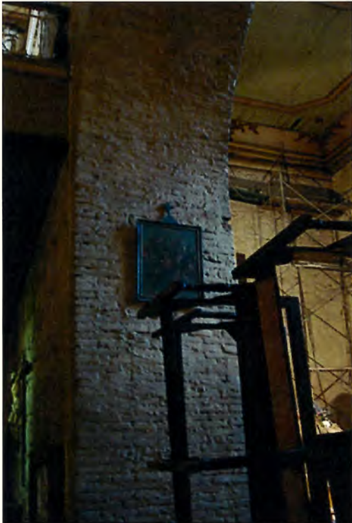
Foto 5: Muestra el trabajo de albañilería de los muros.
