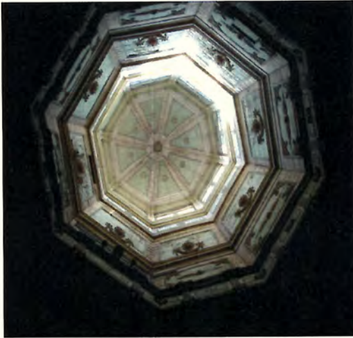
Foto 9: Muestra el lucernario desde donde solo cayeron dos vidrios durante el terremoto.
